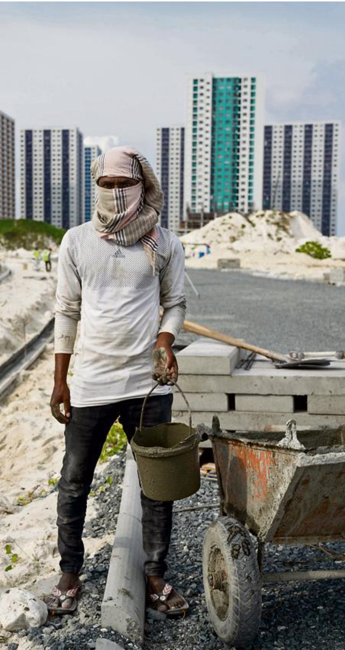
Un ouvrier travaille sur un chantier sur l'île d'Hulhumalé (Maldives), le 11 février. L'île artificielle, qui s'élève à 2 mètres au-dessus du niveau de la mer, est conçue pour accueillir 230 000 habitants.
